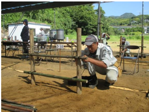
竹垣作製の様子。「裏二の字いぼ結び」で結束中。
