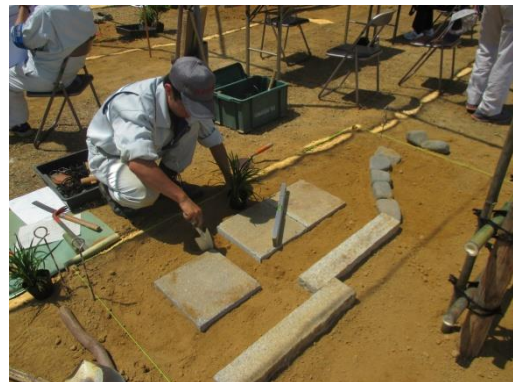
図面通りにミリ単位で石材を据え付けます。
