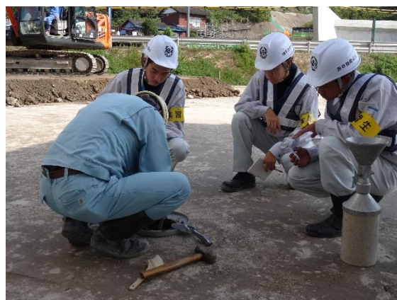
舗装現場での試験
