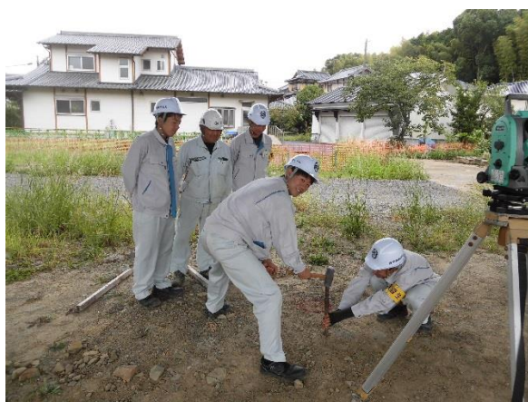
杭をまっすぐに打つのも難しい・・・
