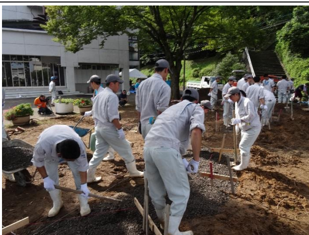
掘った部分に基礎の碎石（砂利） を入れていきます。
