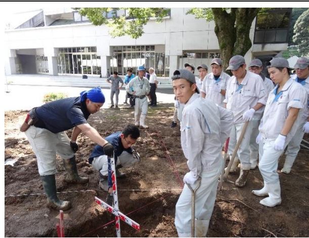
水系に合わせて適切な深さまで 掘削を行います。
