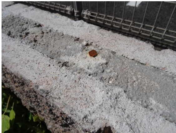
施工前の状況
