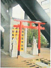
13階の「朝日稲荷」。後ろの柱が「メカトラス」の一部
