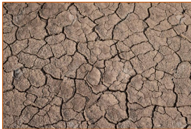
写真3（地面のひび割れ）
