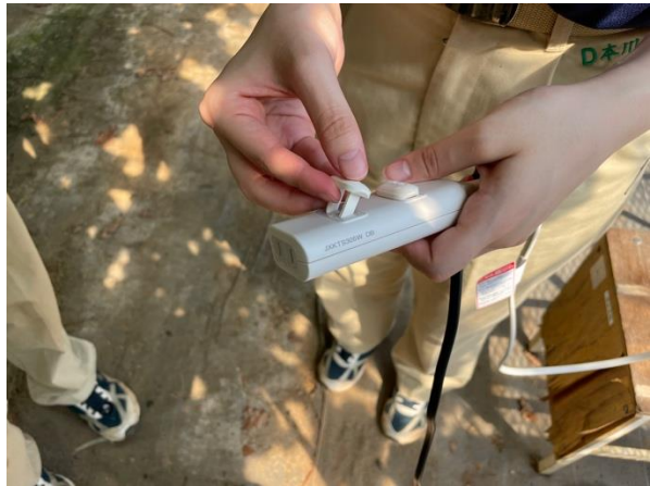
テーブルタップにカバー設置
